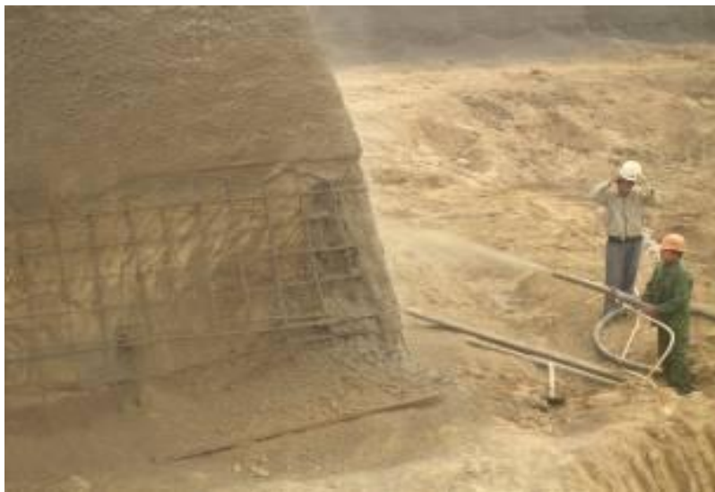
图1.1.2.2 土方分层开挖
