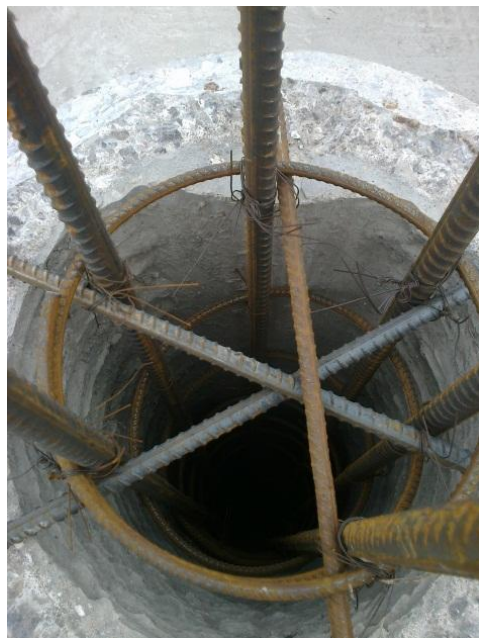
图1.2.3 预应力管桩灌芯
