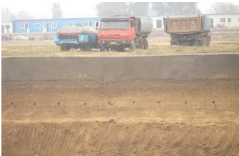
图1.1.1.3 土方分层开挖
