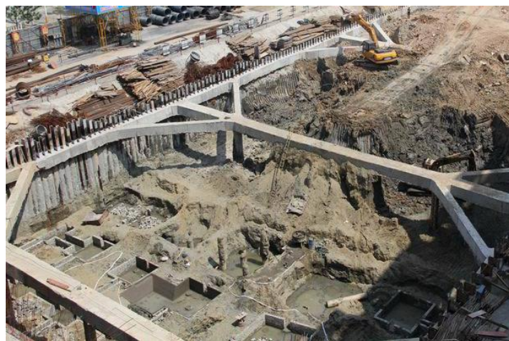
图1.1.1.2 土方开挖支撑
