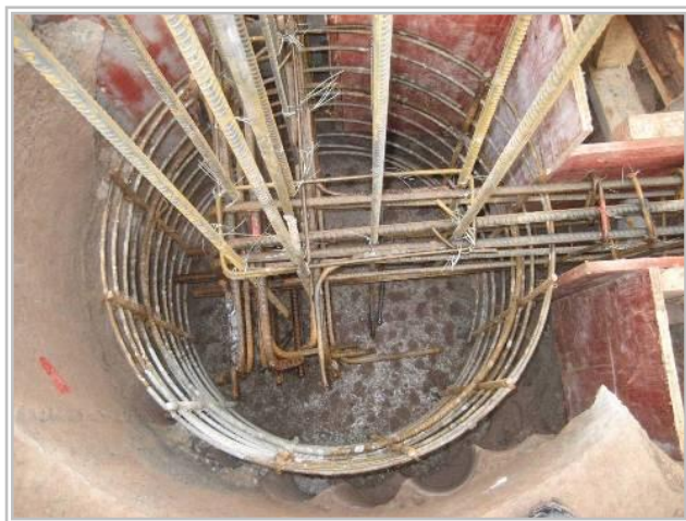
图1.2.5 桩顶浮浆处理
