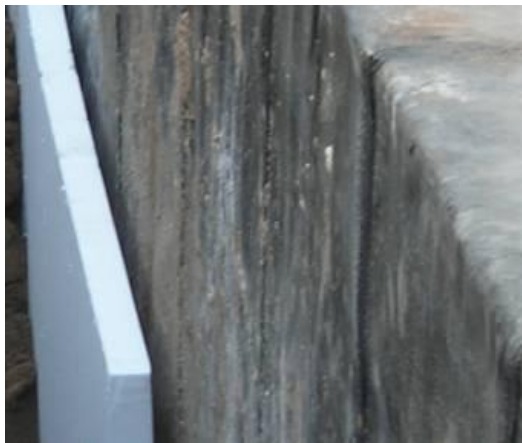
图1.1.3.1 外墙防水成品保护
