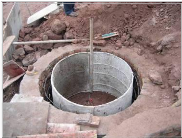
图1.2.4土方分层开挖
