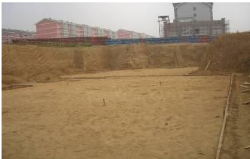
图1.1.1.4 土方开挖支撑
