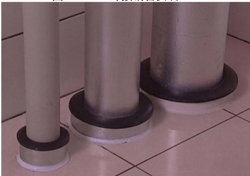
图1.1.1.5 套管安装
