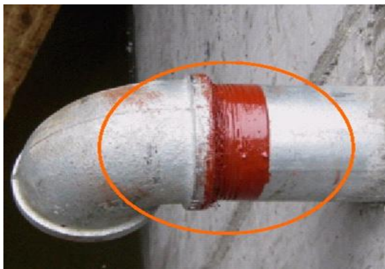
图1.1.1.3.2 镀锌钢管安装
