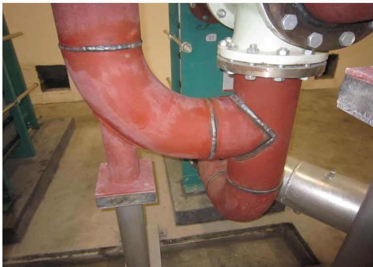
图1.1.1.4 焊接钢管安装
