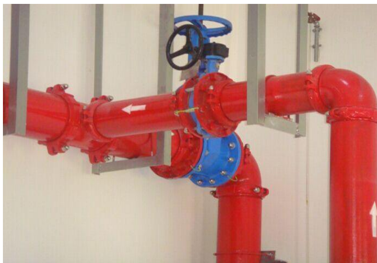
图1.1.1.3.1 镀锌钢管安装
