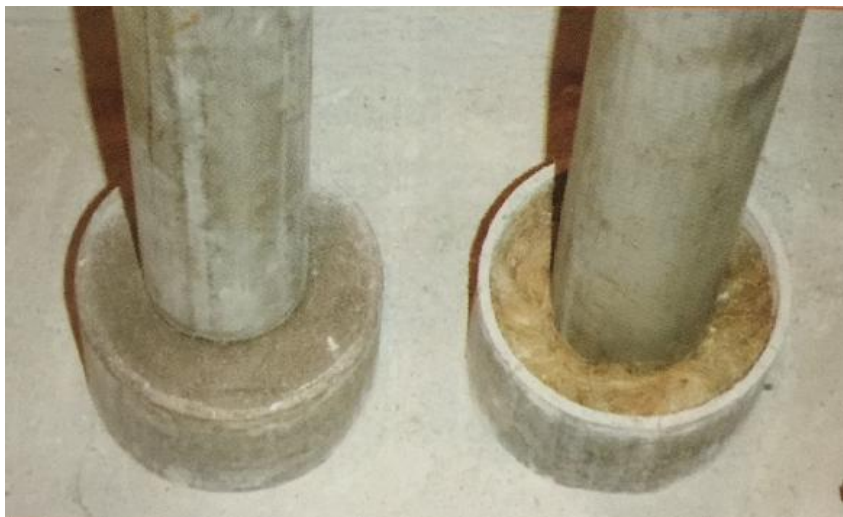
图1.1.1.6 普通套管打口
