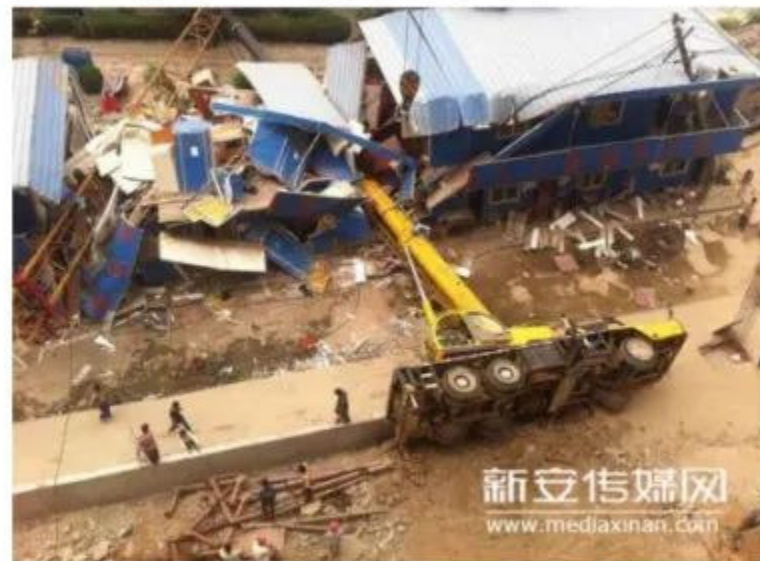
塔吊安装、顶升、拆卸工作不容忽视
