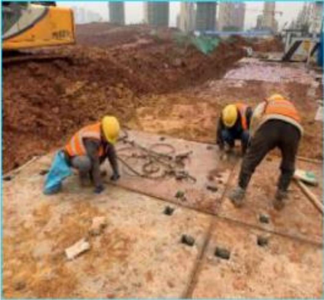
马道采用混凝土余料预制基坑马道板，实现了余料的重复利用，减少了材料的浪费，且基坑马道板可周转重复利用，节约了大量成本。
