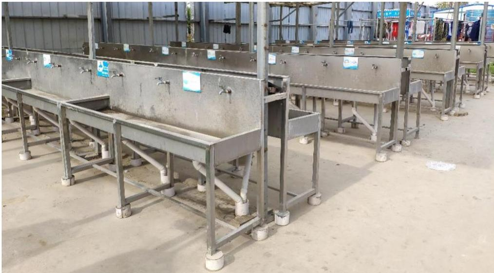
临建工人生活区采用不锈钢洗手台代替常规砖砌洗手台。采用可周转不锈钢洗手台不仅经久耐用、可周转，相比采用砖砌洗手台费用大幅降低。不锈钢洗手台一次投入增加成本 2.1 万元，考虑周转使用
