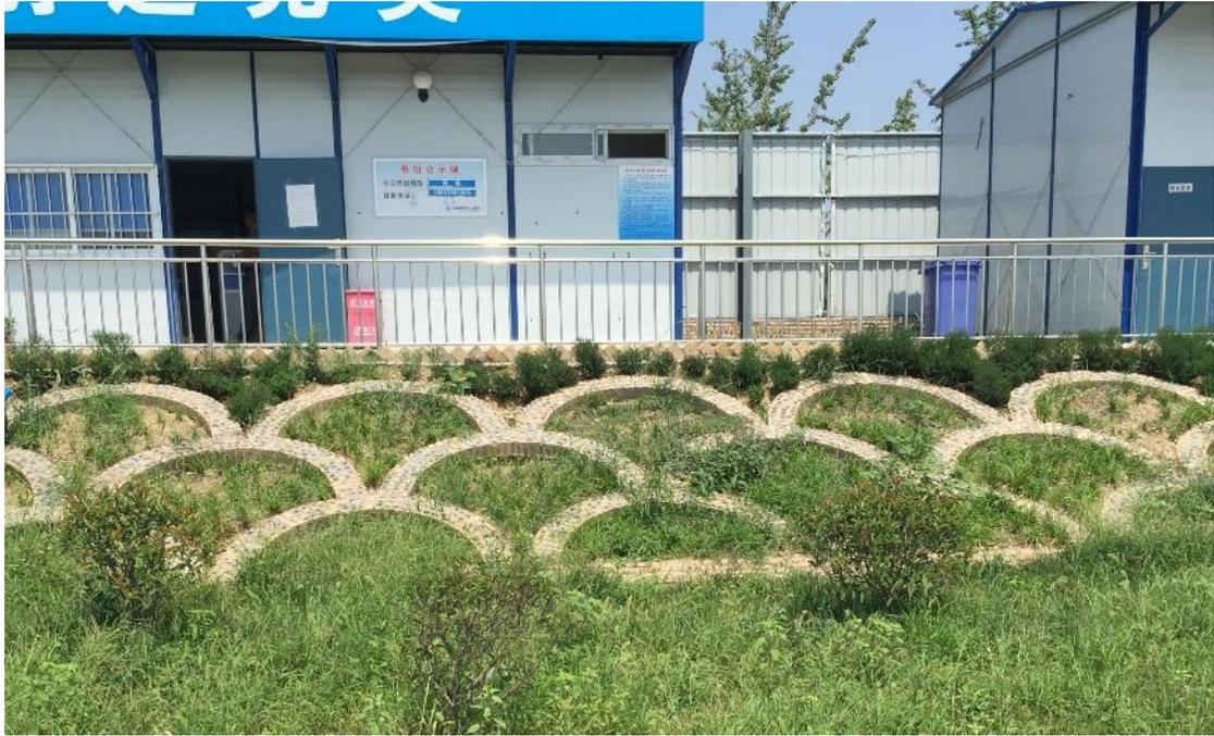
临建办公、生活区采取边坡绿化的方式对边坡进行防护。生活区护坡菱形砌砖，中间种草护坡，绿色美观同时节省时间、费用。此种绿化护坡方式，护坡效果良好，有效防止水土流失；同时美化环境，有效防止扬尘。
