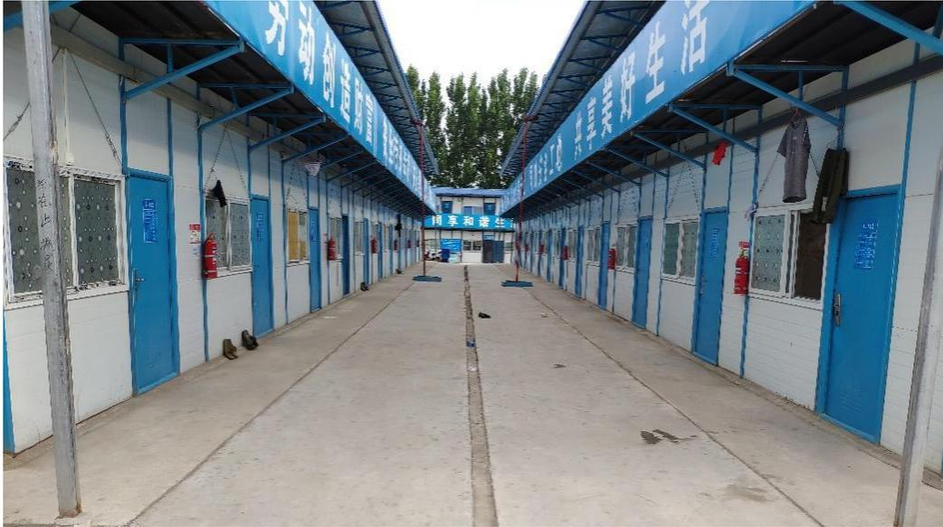
工人生活区板房卫生间排水沟由原来每栋板房间的大沟改为小沟，通过地面找坡与排水沟找坡共同排水。此做法减少了排水沟的工程量，同时，在使用过程中，排水沟无须盖板，易清理；累计节约成本 1.3 万。
