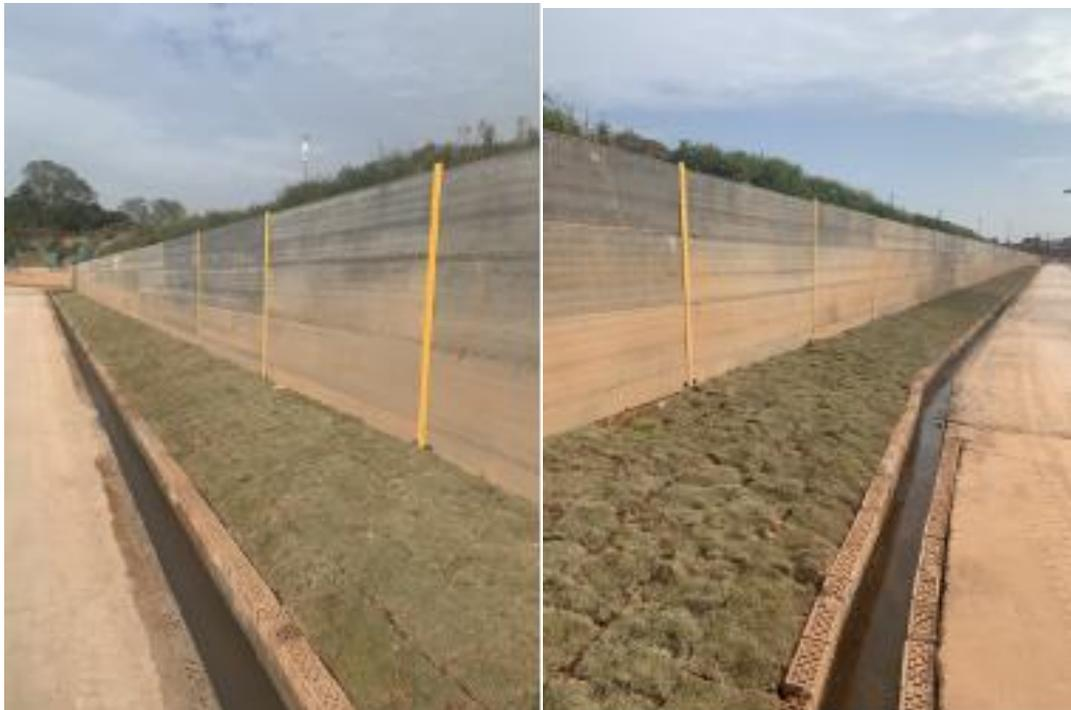
施工现场东侧道路采用装配式预制水泥板可周转围墙，工期较之传统砌体围墙大大缩短，节约了大量的人力物力，具有良好的经济效
