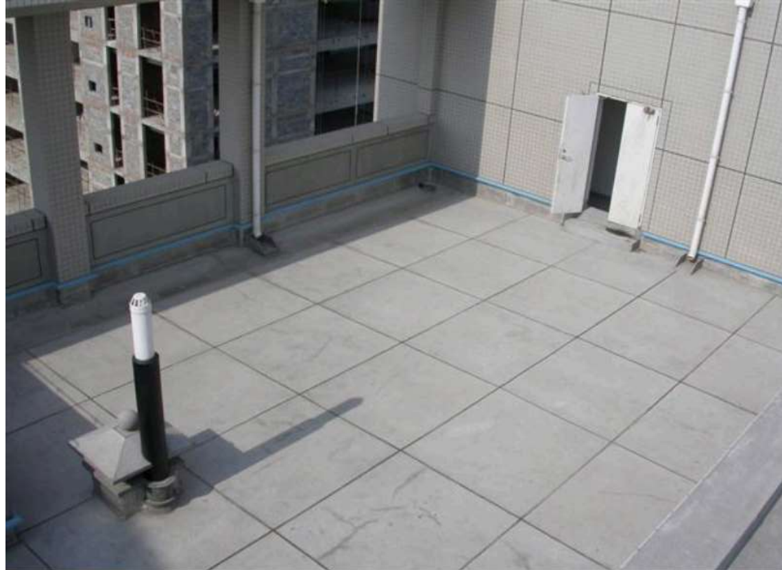
混凝土面层屋面
