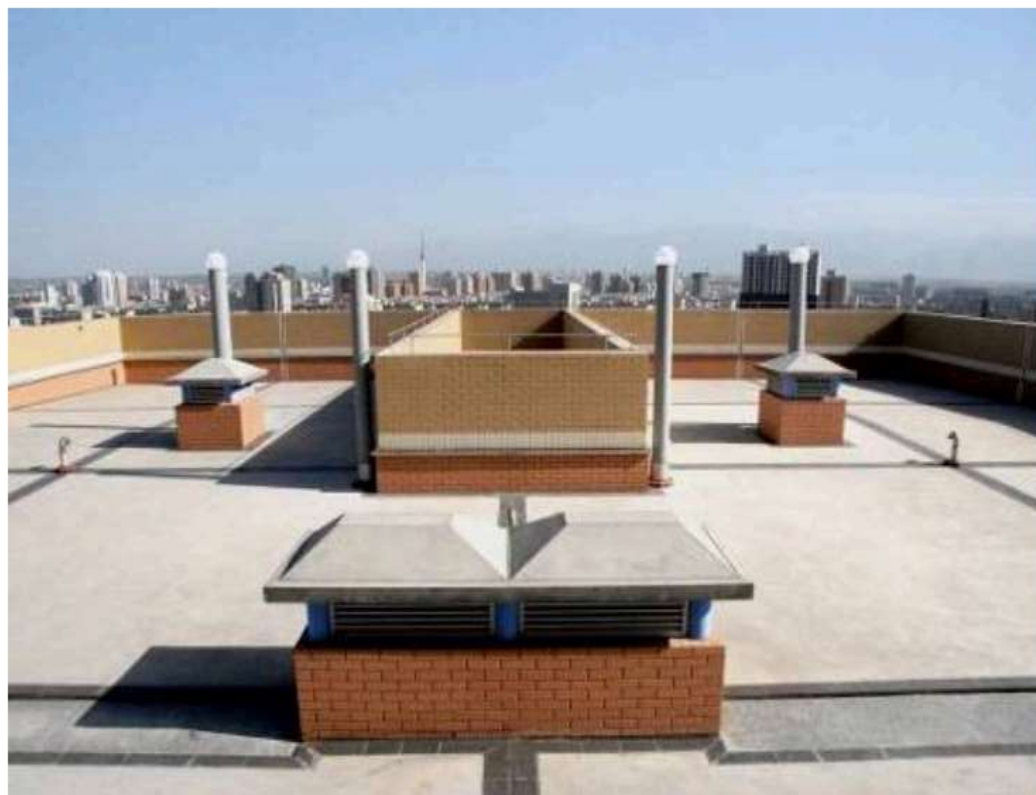
混凝土面层屋面
