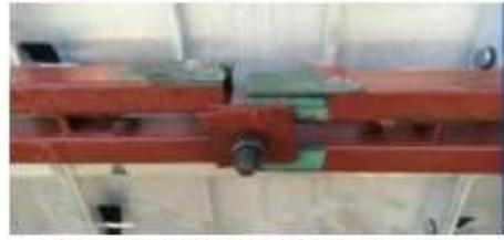
背楞搭接部位对拉螺栓加固不合理
