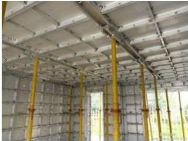
墙柱模板未安装斜撑
