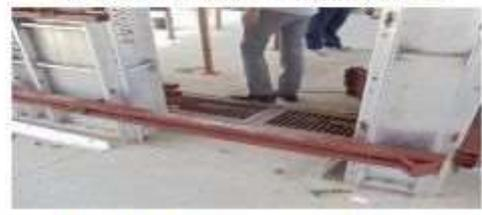
墙柱侧模加固不到位，对拉螺栓未安装
